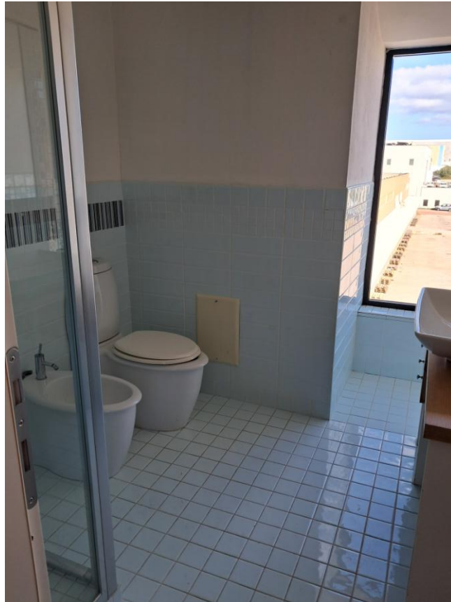
Foto 8: ufficio sub 31- bagno locale 1
